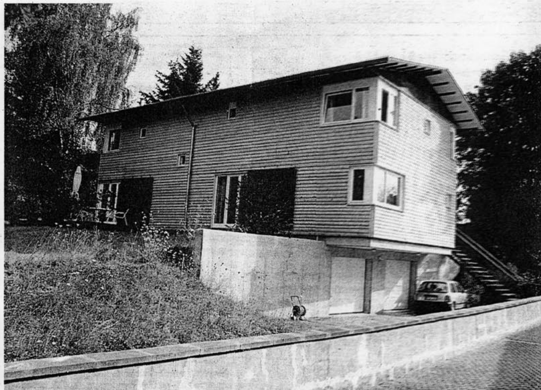
Holzrahmenbau über Betonsockelgeschoss von Arch. Rudolf Huber in Regensburg-Oberisling.
